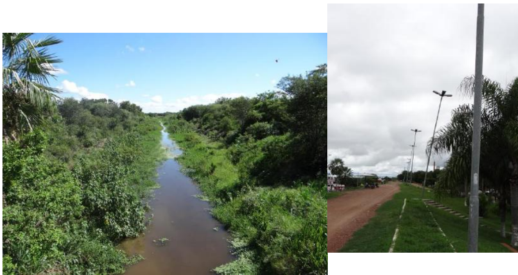
Figura 3 – a esquerda um dos canais de drenagem que foram construídos com a finalidade de drenar as águas na cidade. A direita observa-se os postes inclinados próximo ao dique, devido a tráfego de veículos e pessoas.
