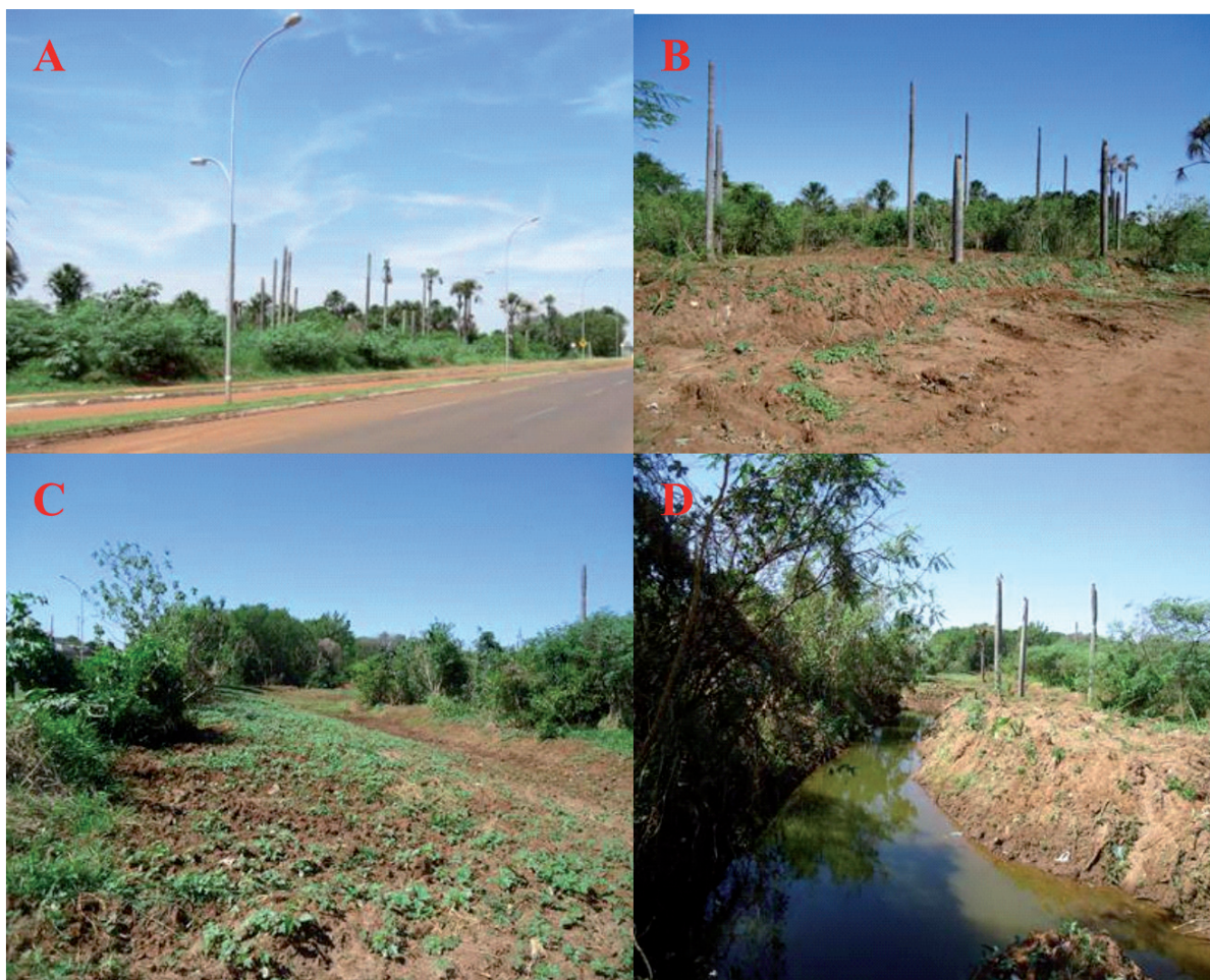
Figura 6. (A) Área antes da obra de contenção; (B e C) desmatamento da área; (D) córrego Imbirussu, após obra realizada pela Prefeitura Municipal de Campo Grande para contenção de enchentes na área da BAI (20° 26' 03.66"S 54° 40'05.35"O).
