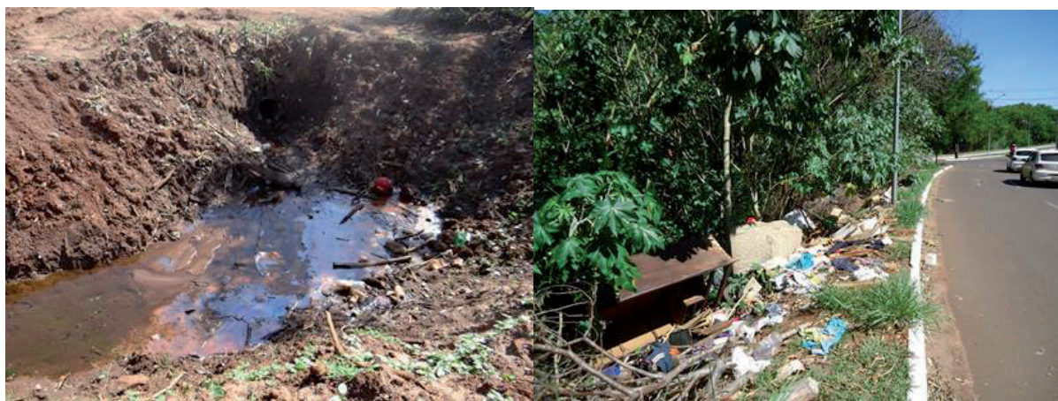
Figura 5. Lançamento de esgoto no córrego Imbirussu (20° 26' 03.66"S 54° 40' 05.35"O) e lixo às margens do Parque Linear Imbirussu (20° 25' 56.81"S 54° 39' 56.11"O).
